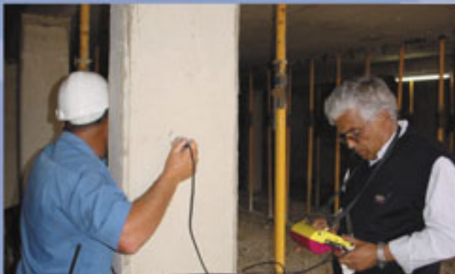
Peritagem com utilização de aparelho de ultrasons
